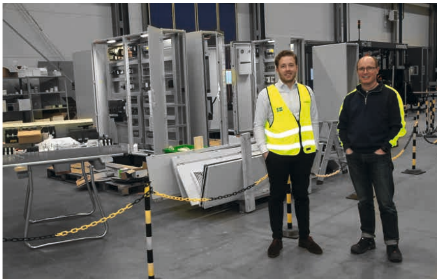
Oskar Wastesson, försäljningsingenjör på Siemens, och Magnus Spåre, senior automationsingenjör på Evomatic, framför några av de 47 skåp som byggdes för en plåtpresslinje.
