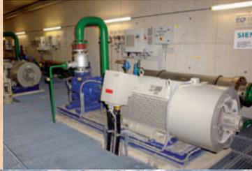
In der neuen Hochdruck-Pumpenstation am Plettsau-Kopf gewährleisten Drehstrom-Asynchronmotoren 1PQ8 einen zuverlässigen Antrieb
