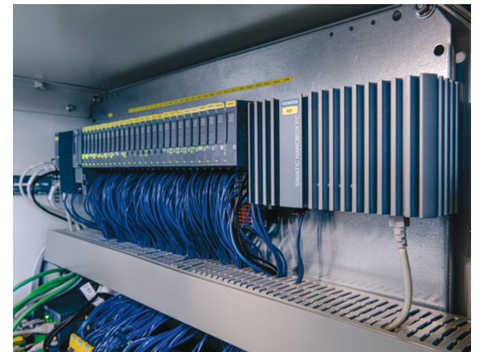
Siemens Industrial Edge besteht aus einer Simatic Nanobox 227E und der zugehörigen Edge Software. Die Daten werden «read-only» von der Steuerung abgegriffen.
