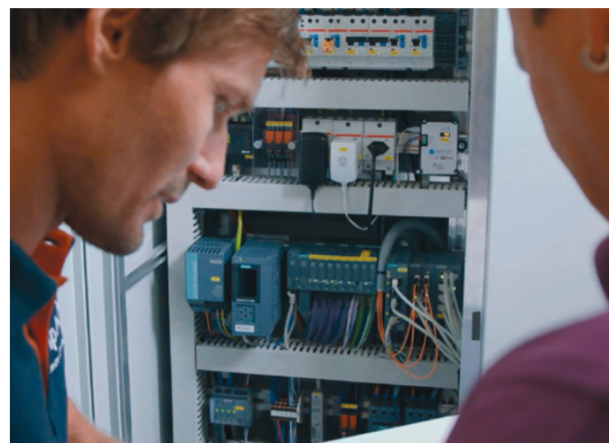
Der Betrieb des Daches erfolgt mit einer Simatic S7-1500.
