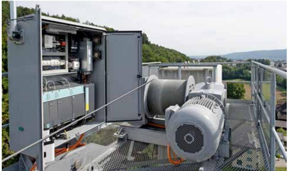
Der Schaltschrank mit der Steuerung und den Umrichtern liegt exponiert auf dem Ausleger des Krans.
