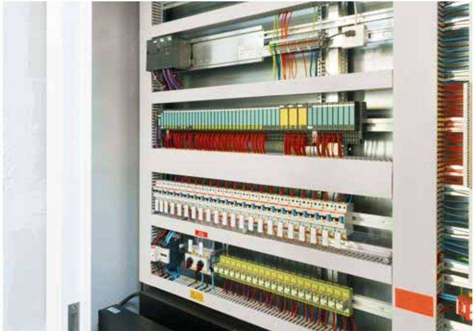
In der Simatic S7-315F Steuerung (links oben) wird sowohl Standardcode als auch fehlersicherer Code ausgeführt. Ebenso sind die Ein-/Ausgabemodule in Standardausführung oder fehlersicherer Version installiert.
