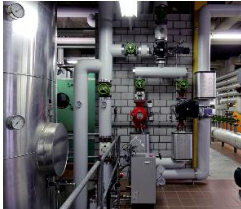
Die Holzsnitzelheizung wird mit Abfall aus dem eigenen Holzbearbeitungsbetrieb «gefüttert».
