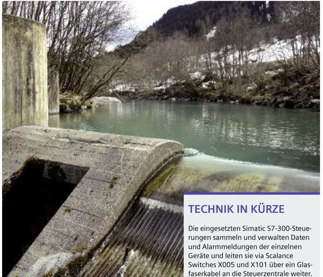
Die Hauptwasserentnahmestelle für das Wasserkraftwerk von Sauterot (Wallis).
