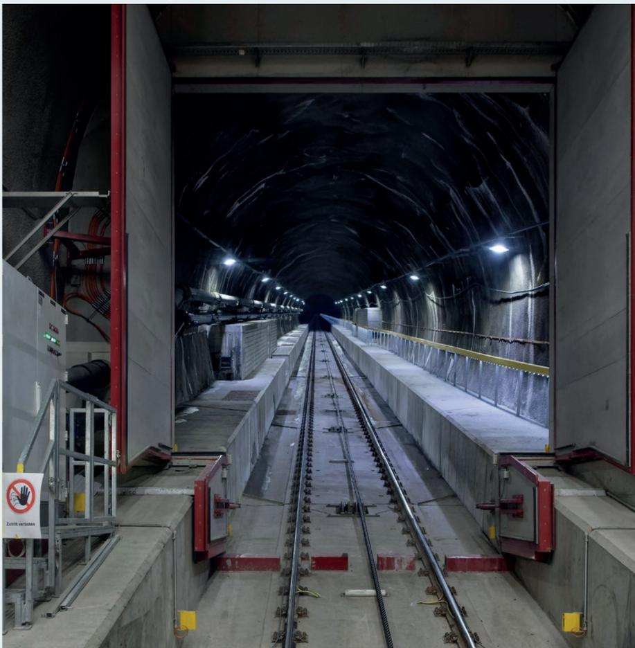
Die FibroLaser-Technologie und eine Entrauchungsanlage von Siemens schützen den rund vier Kilometer langen und unterirdisch angelegten Zugangsstollen des Pumpspeicherwerks Limmern.
