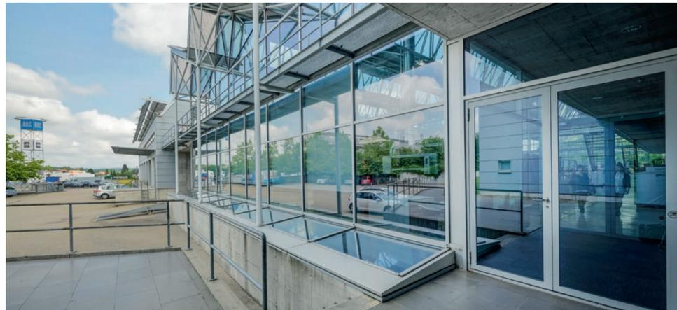
Die älteren Module der Seitenfassade mit 2-fach-Verglasung werden laufend durch Module mit 3-fach-Verglasung ersetzt.
