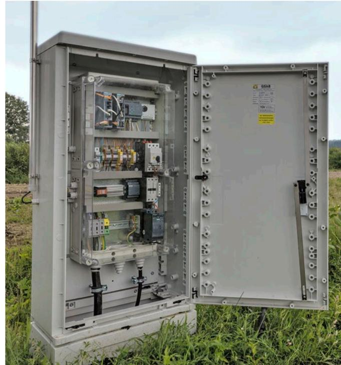
An den Feldrändern installierte Schaltschränke mit Steuerungskomponenten sorgen für eine ausreichende Versorgung der Sprinkleranlage
