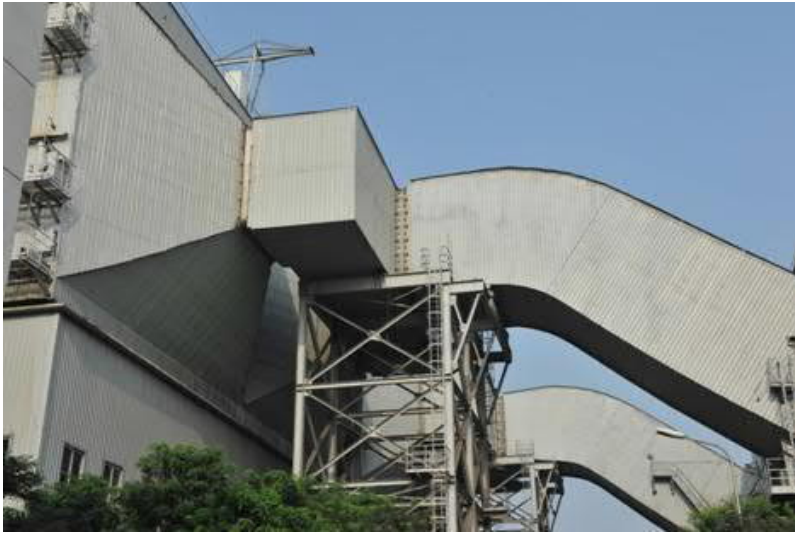
太钢四号烧结风机系统外景
