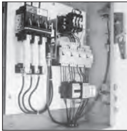
Sectionneur de type MCS avec poignée de commande Max-Flex MC
