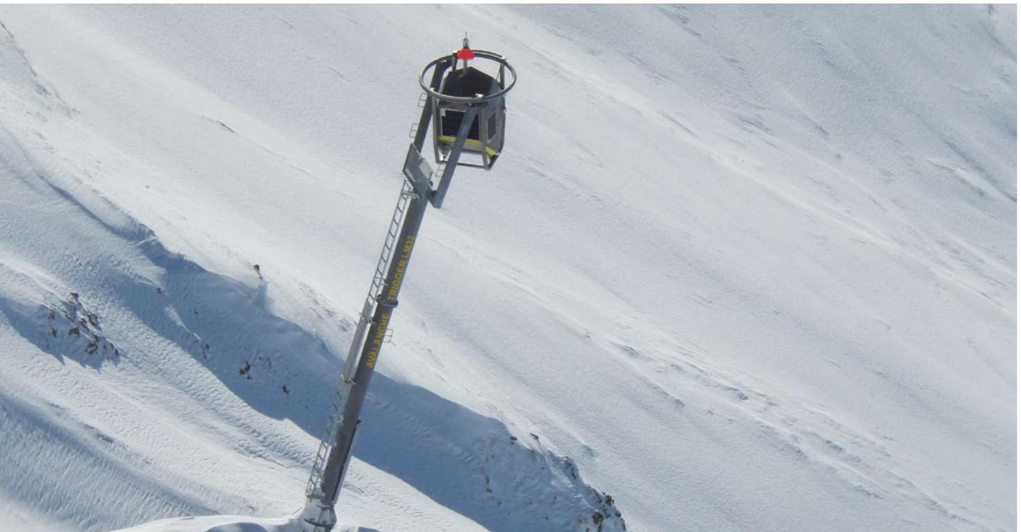
Der Mast steht schräg im Gelände. So detonieren die Sprengladungen mit genügend Abstand zum Fundament.
