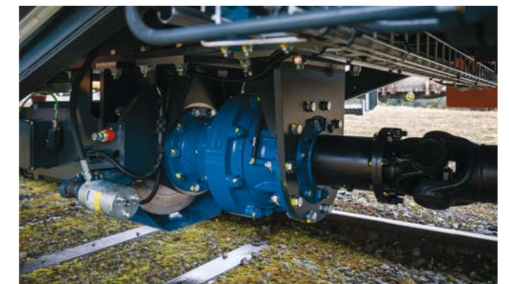
Effizient und leise: Ein 1PH8 Simotics M Kompakt-Synchronmotor mit einer Leistung von 69 kW bewegt den Wagen während der Fahrleitungsarbeiten.
