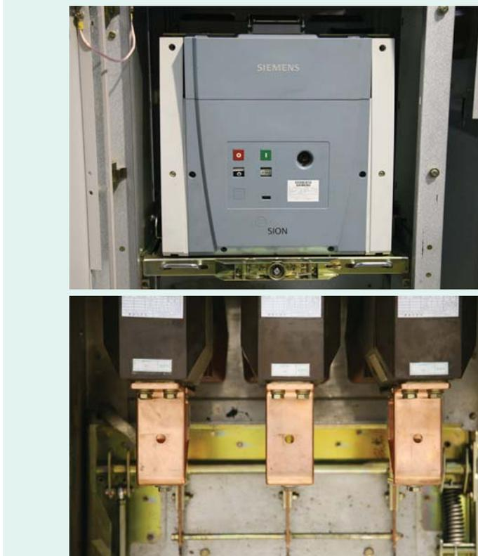
Подходит для номинального тока отключения короткого замыкания  $\leq 31,5 \text{ кА}$  и номинального тока  $\leq 2 \text{ 500 А}$  со стандартным или УБП-выключателем
