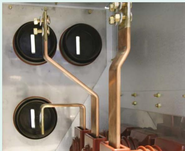
Конструкция отсека сборных шин с номинальным током 1 250 А и номинальным током отключения короткого замыкания 25 кА
