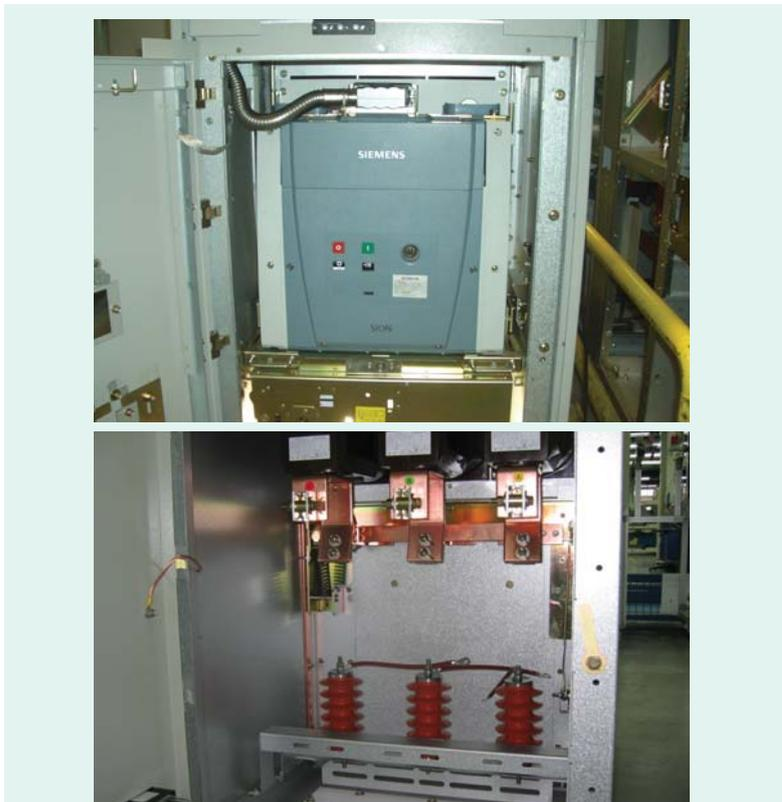
Подходит для номинального тока отключения короткого замыкания  $\geq 31,5 \text{ кА}$  и номинального тока  $\geq 3 \text{ 150 А}$  с классическим выключателем
