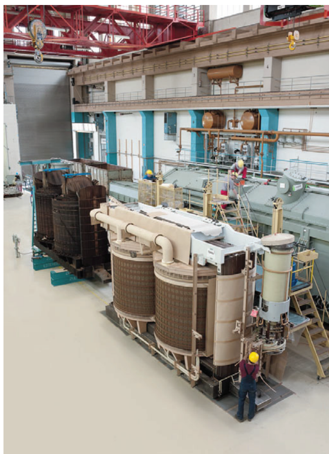
Рис. 5.11-6: Цех ремонта в Нюрнберге, Германия
