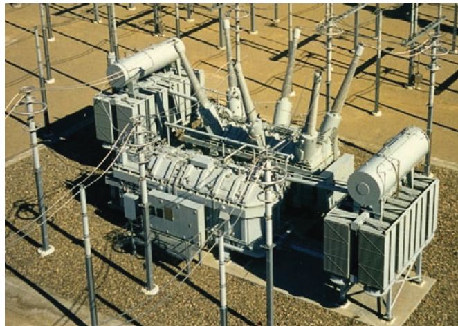
Рис. 5.7-1: Фазоповоротный трансформатор
