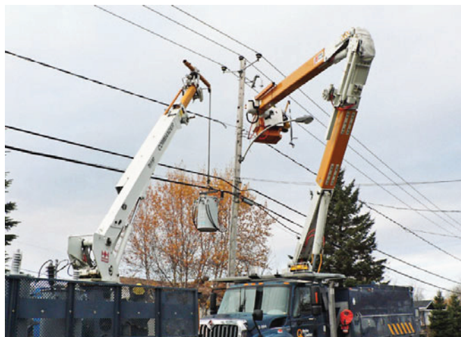
Рис. 5.9-1: Трансформатор для установки на опоре, Канада
