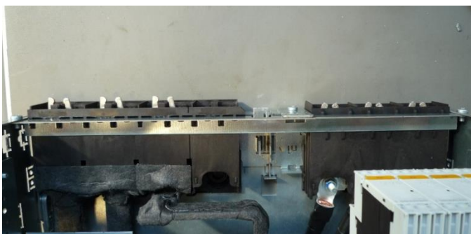
Figuras passo 1 - Deslocar para fora os contatos de ruptura / Pictures step 1 - main contacts drive out
