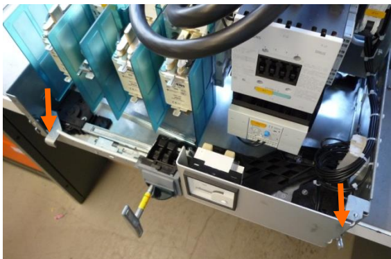
Figuras passo 1 - Deslocar para fora os contatos de ruptura / Pictures step 1 - main contacts drive out
