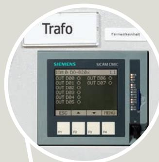
SICAM CMIC integriert im Antriebsvorbau des Transformatorabzweigs der 8DJH
