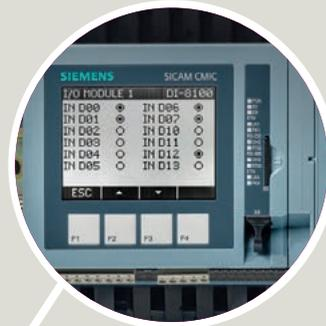
SICAM CMIC eingebaut im Niederspannungsschrank auf der 8DJH Schaltanlage
