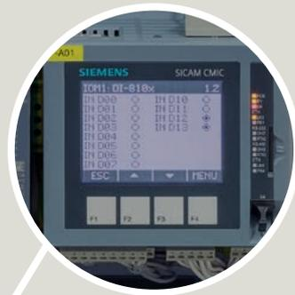
SICAM CMIC eingebaut in Ultra-Box innerhalb der Ortsnetzstation
