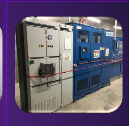
Acomplamiento con barra en Media y Baja tensión
