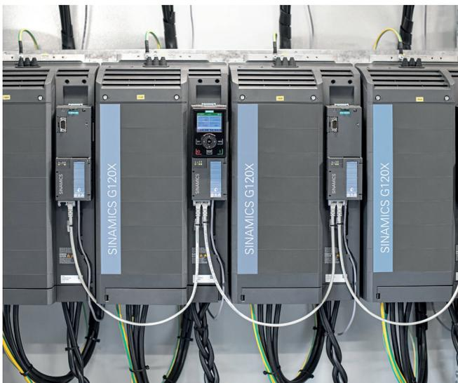
Die neuen Frequenzumrichter Sinamics G120X für drahtlose Inbetriebnahme, Diagnose und Service sind speziell für den Betrieb an Pumpen und Lüftern entwickelt worden.
