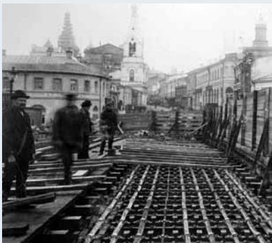
Maßarbeit: Die Lichtgesellschaft ließ in Moskau 1898 Kabel von Siemens & Halske verlegen
