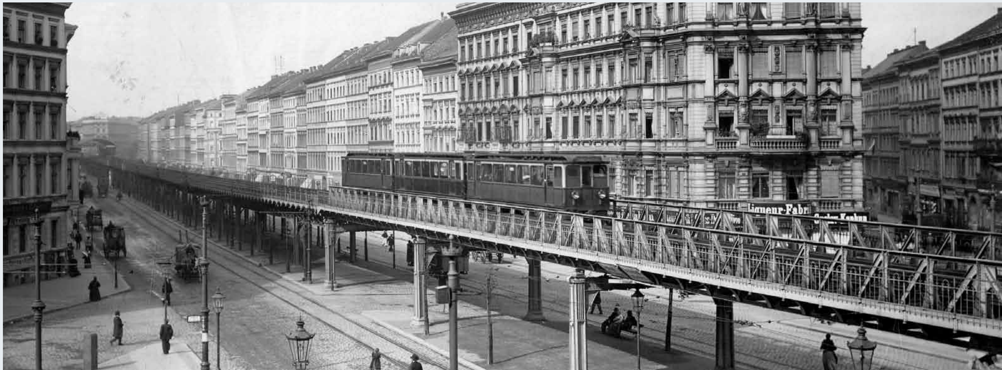
Ungewohnter Anblick: die neue Berliner Hochbahn – hier die U1 in der Skalitzer Straße, Ecke Oranienstraße
