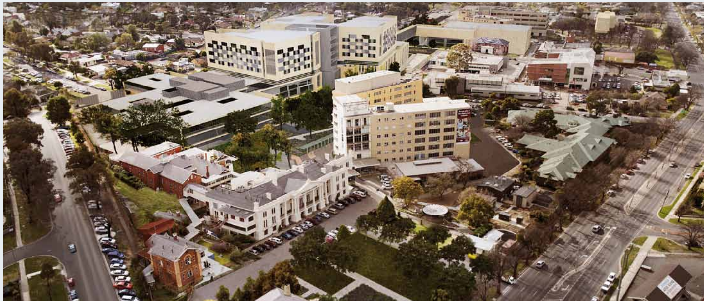
Das neue Bendigo Hospital wird im Rahmen einer Public-private-Partnership finanziert
