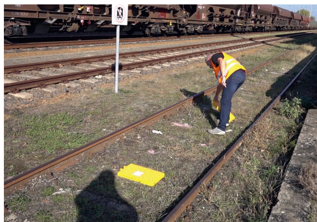
Bild 3: Verlegen der Balisengruppe für die ETCS-Level-2-Testfahrten in Finsterwalde
