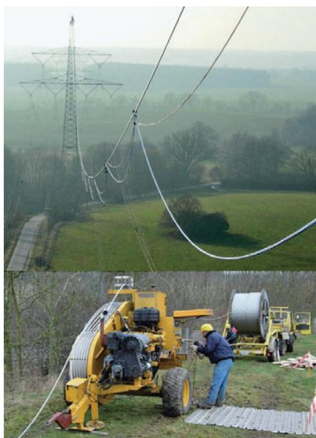
Рис. 8.2-8: Монтаж под напряжением оптического кабеля, встроенного в грозозащитный трос
