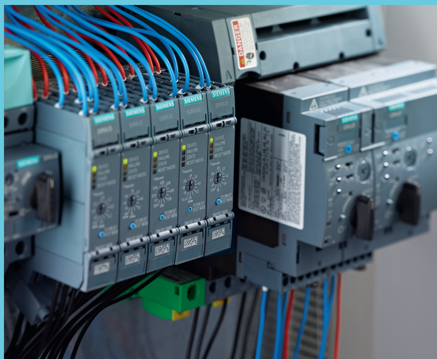
▲ Obr. 1: Velice kompaktní, multifunkční a hospodárné spouštěče Sirius 3RM1 pro motory do 7 A (vlevo) rozšiřují portfolio kompaktních spouštěčů 3RA6 pro motory do 32 A (vpravo).
