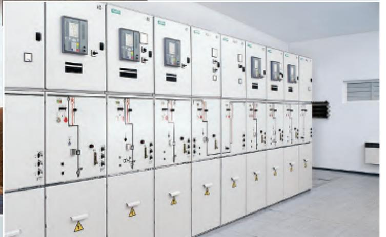
Распределительное устройство NXPLUS C 20 кВ (пример)
