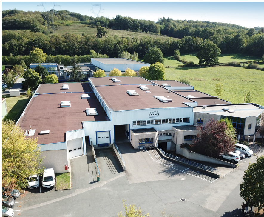
A Civrieux d'Azergues, MGA Technologies dispose de 6 300 m 2 d'atelier et de bureaux, dont 300 m 2 de salle de montage propre.
