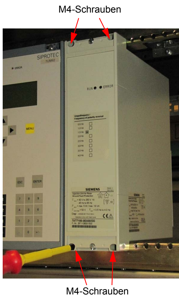
Bild 8-3 Einbau des Gerätes in die Schalttafel
