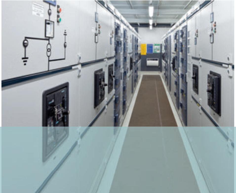
**Schaltanlagen Sivacon S8 – hier im Schalthaus 6 bei ThyssenKrupp Electrical Steel – bieten geprüften Personen- und Anlagenschutz auch unter Störlichtbogenbedingungen**
