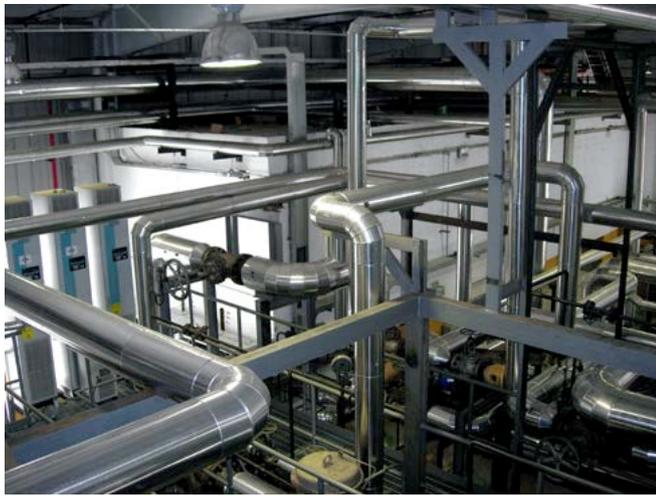
**Bild 1:** Rohrleitungen der SCHEITER® Heißwasseranlage mit Rückgewinnungssystem einschließlich aller Nebenanlagen für die Reifenindustrie
