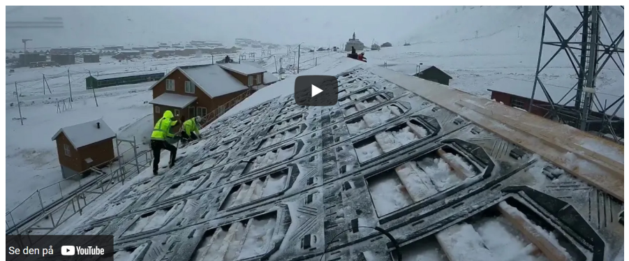
Tidlig i oktober installerte Kverneland 170 solcellepaneler på Telenors bygg på Svalbard, totalt 63,75 kWp, som gir en årlig produksjon på 31 268 kWh.
