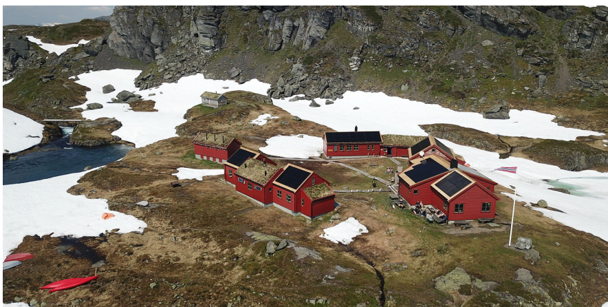
Kverneland Energi AS er tildelt kontrakten for levering av mikronett til Stavangerregionen Havns anlegg Utenriksterminalen i Risavika.
