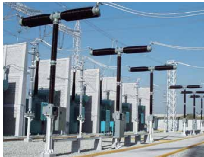
3AP2 FI 420 kV
