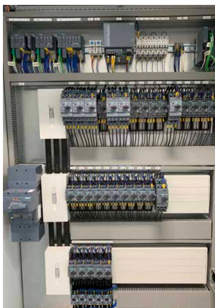
Effektbrytare, startapparater etc. monterade på montageplattor i ett skensystem.
