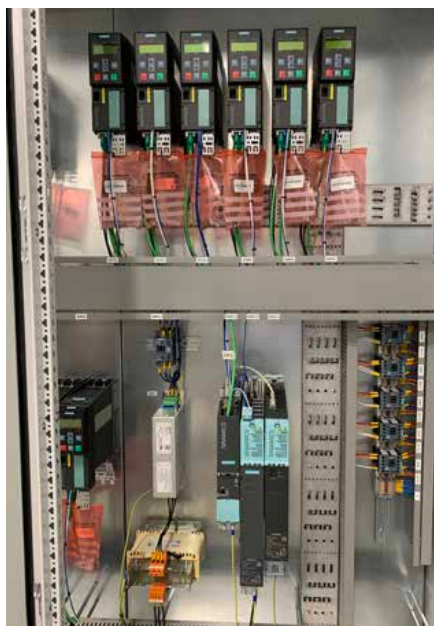
För att köra servomotorer med höga prestandakrav har man valt Sinamics S120, i detta utförande med en återmatande linemodul – Smart Line Module.
