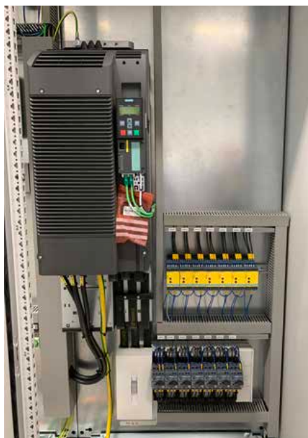
Frekvensomriktaren Sinamics G120 är modulär, vilket innebär att man kan använda samma kontrollenhet till olika effektmoduler.
