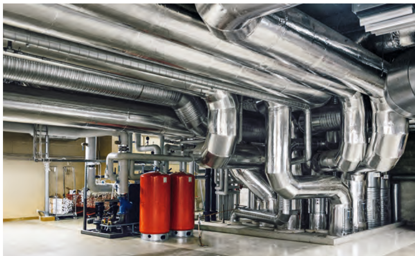
Sistem za nadzor, krmiljenje in optimizacijo razsvetlitve, ogrevanja in prezračevanja prinaša finančne prednosti za nakupovalni center in najemnike lokalov v njem.
