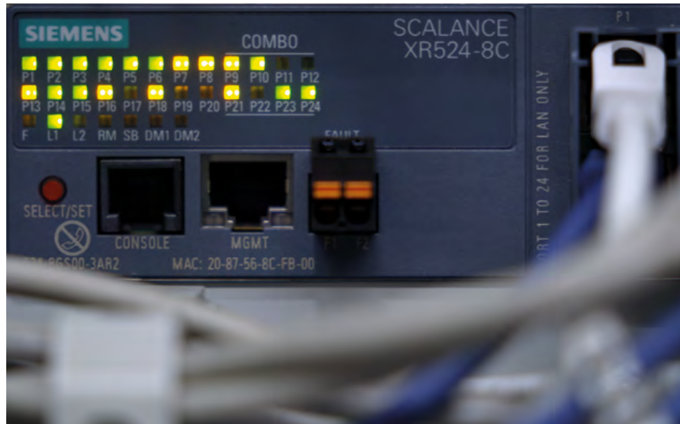
Scalance XR524-BC-Switch als Rückgrat des Produktionsnetzwerkes
