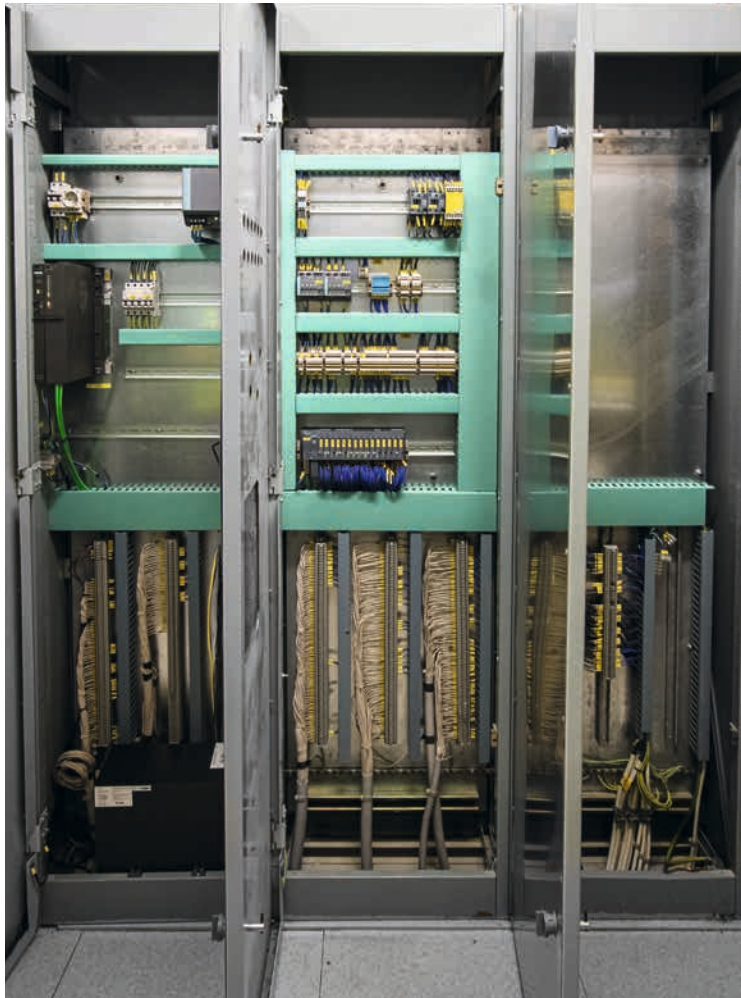
Moderniserade styrschåp – propra och luftiga med integrerad säkerhet och gott om plats för framtida utökningar.
