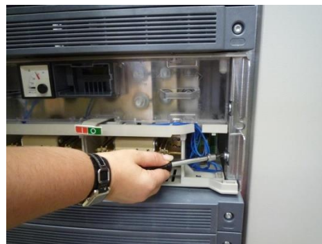
Fig. 13 / Fig. 13: fixação da barra conectada à direita / Fastening the plugged-on strip right
