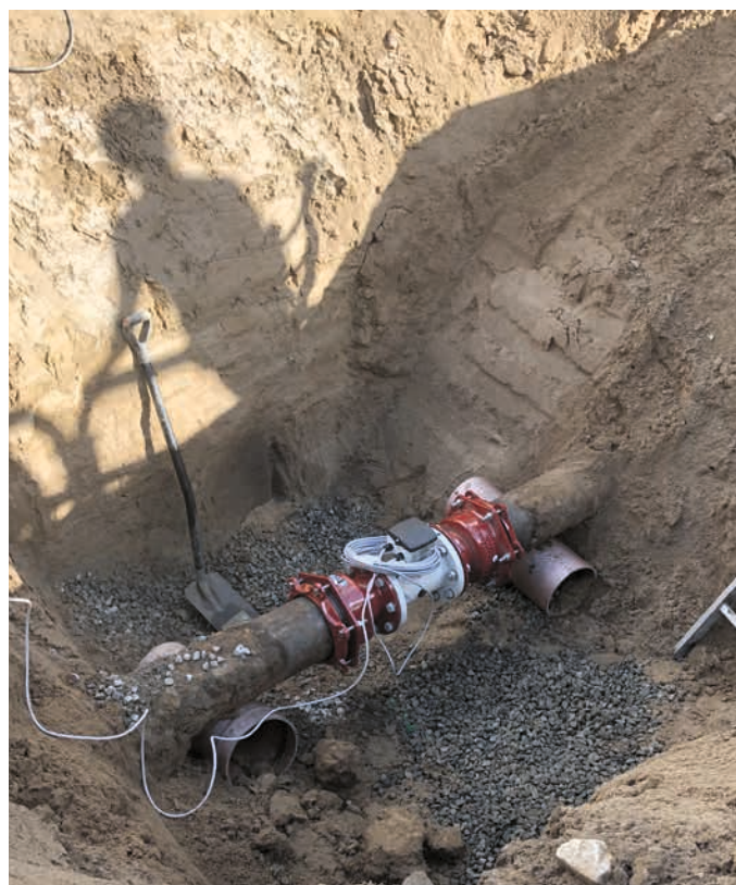
Siemens flödesmätare Sitrans FM MAG 5100W fälls in på dricksvattenrör i pågående mätzonsprojekt.
