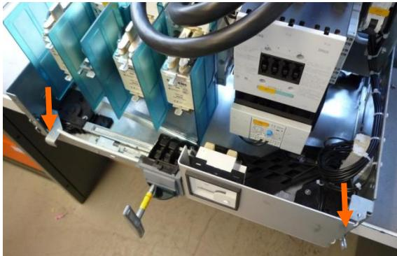
Figuras paso 1: extracción de los contactos de seccionamiento / Pictures step 1 - main contacts drive out
