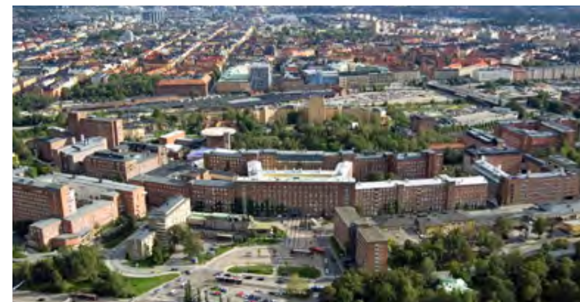
Nya Karolinska blir första sjukhus att miljöcertifieras, bland annat tack vare energisnål byggnadsteknik från Siemens.
