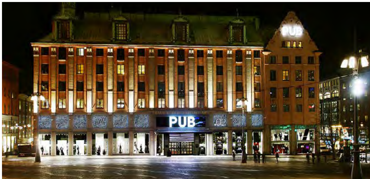
Upplyftande! Siemens stod för hissinstallationerna när det anrika PUB-varuhuset invigdes i Stockholm 1925.
