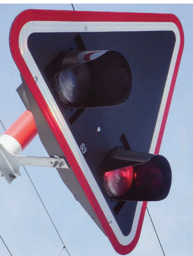
In den Blinklichtsignalen sind LED-Signalgeber eingebaut.
