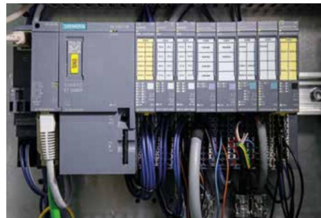
L'installation est commandée par des modules Simatic ET 200SP et Simatic S7-1500, les éléments de commande sont complétés par un variateur Synamics G120.
