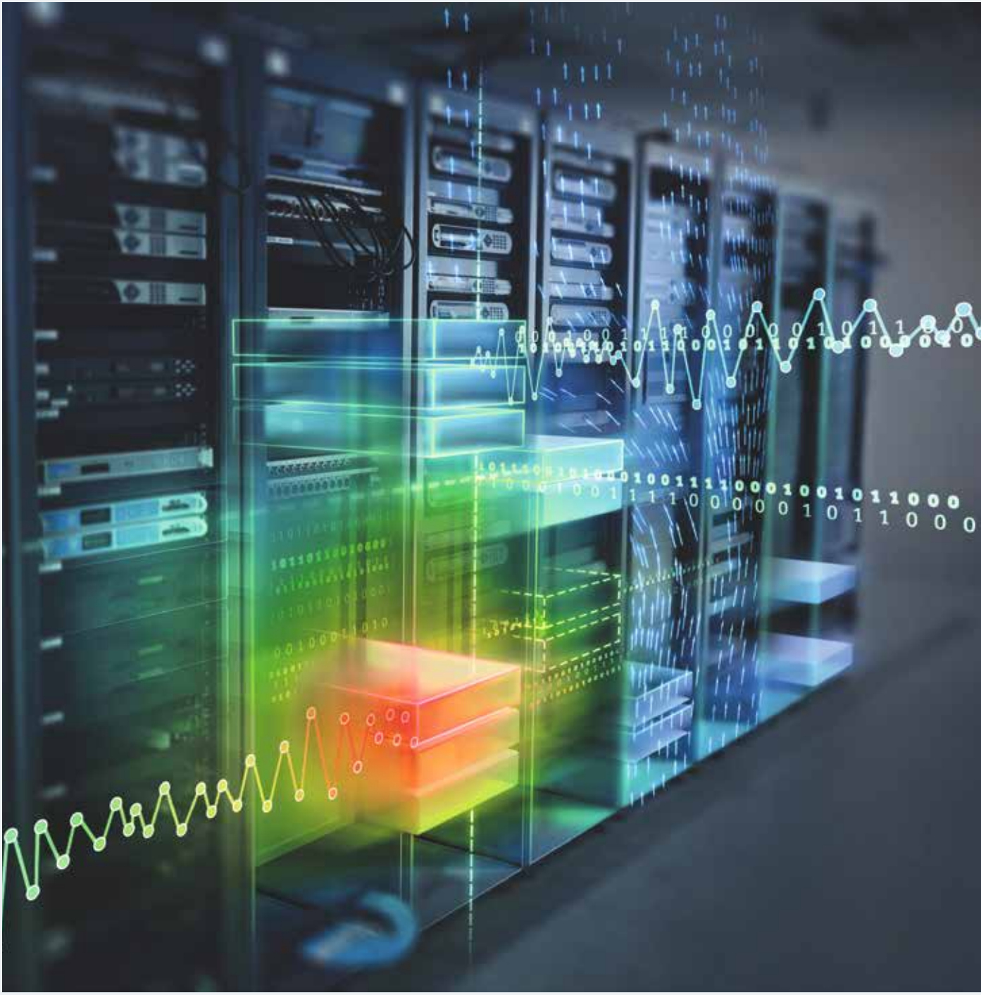
In collaborazione con Vigilent, Siemens amplia il suo ventaglio di offerte per l'ottimizzazione termica nei centri di calcolo.
