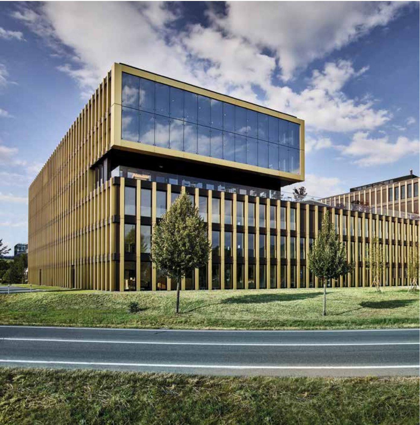
La soluzione d'ombreggiamento controllata da componenti Siemens assicura un clima sempre gradevole all'interno del Quadrolith.
