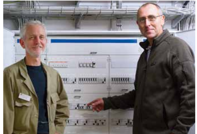
Zehn Brandschutzschalter von Siemens sichern im Karolinen-Hospital Hütten besonders sensible Stromkreise gegen serielle Fehlerlichtbögen.
