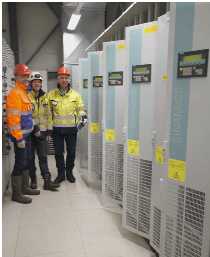
Frekvensomriktare med integrerad säkerhet: Sinamics G150 i skåpsutförande.
