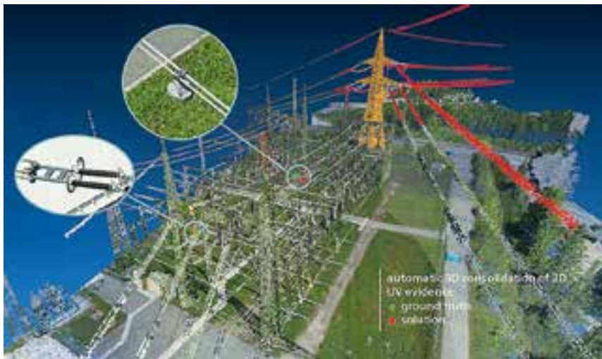
По време на оглед от въздуха в подстанция край Глайдсдорф бяха регистрирани UV-дефекти и сравнени с измервания от земята – достоверността на резултатите беше повече от убедителна
