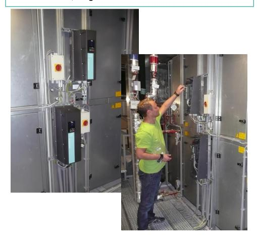
Schwieriger Zugang zum Antrieb für Inbetriebnahme, Diagnose und Wartung, der im Inneren der AHU montiert ist, z. B. bei einem Gerät am Dach oder bei rauen Umgebungsbedingungen
