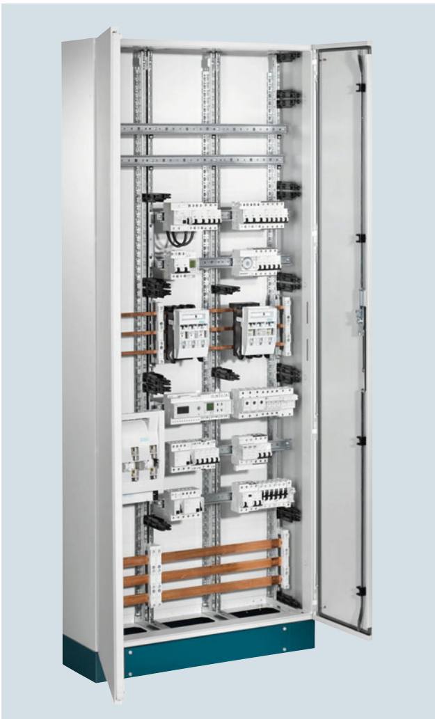
Abb. 5/19: Ansicht eines offenen Unterverteilerschranks ALPHA 630
