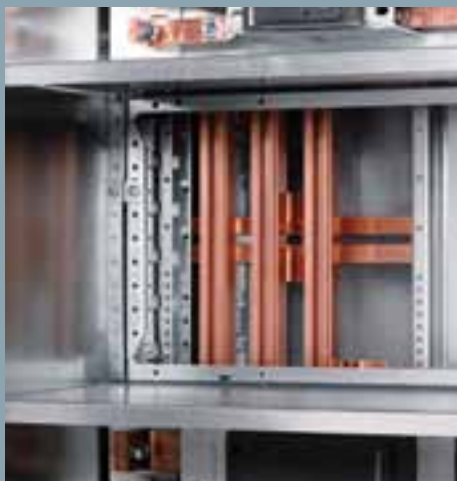
Вертикальные распределительные шины
