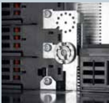
Кодирующее устройство в отсеке
