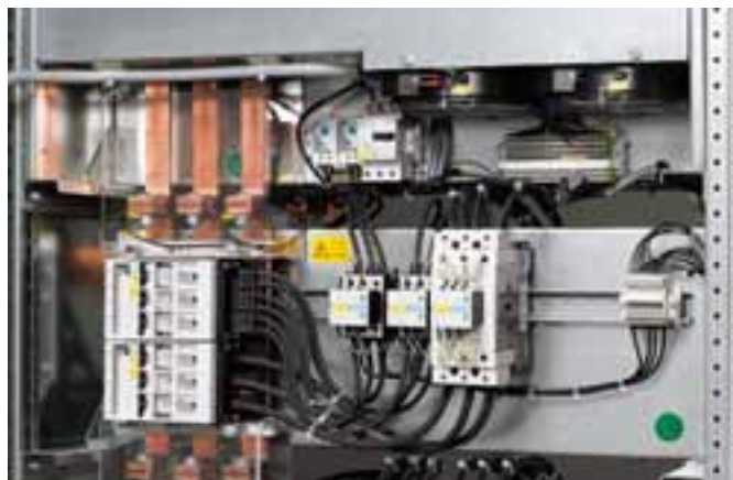
Модуль конденсаторов 100 кВАр
