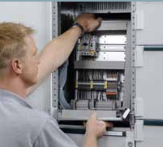
Съемная плата со вспомогательными аппаратами
