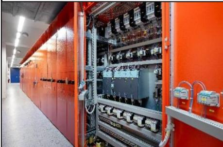
Die Niederspannungsschaltanlage Sivacon sorgt für die intelligente Energieverteilung bei Perlen Papier. Die Papiermaschine PM7 verbraucht im Maximalbetrieb 18MW Strom.
