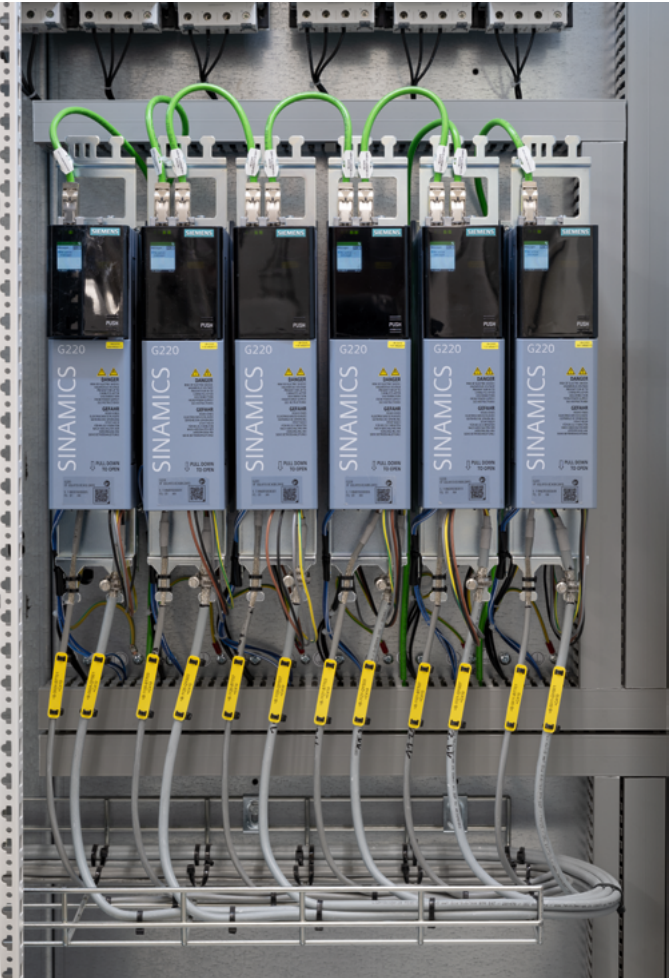
Die Sinamics G220 Frequenzumrichter meistern Schweranläufe und optimieren Prozessparameter – auch bei kleinen Testmengen im Grain Innovation Center.
