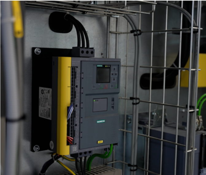
Um die Maschinenteile im Grain Innovation Center weniger zu belasten, lassen die kompakten Sirius Sanftstarter 3RW die Elektromotoren schonend anlaufen.
