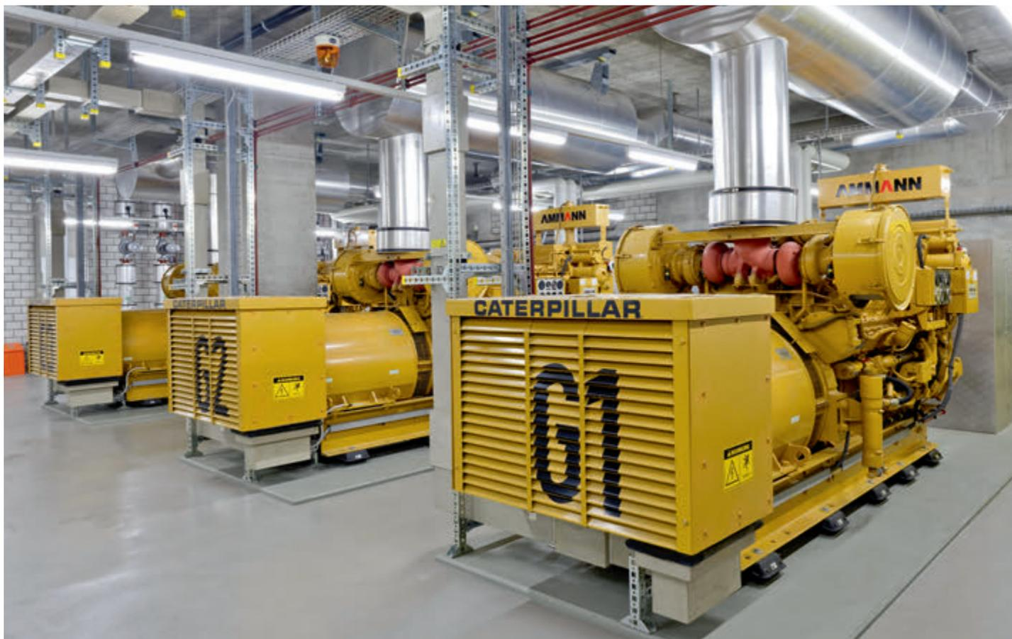
Das Kernstück der Notstromversorgung bilden drei Caterpillar-Dieselegeneratoren mit einer Leistung von je 1250 kVA.
