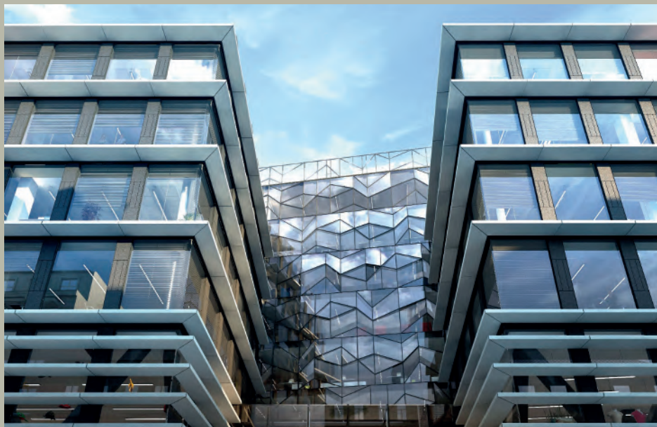
Komplexní systém měření a regulace pro multifunkční centrum Quadrio v Praze
