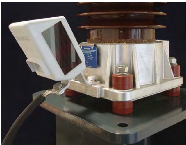
Bild 13: Unterer Ableiterflansch mit Isolierfüßen und montiertem Leckstromüberwachungsgerät
